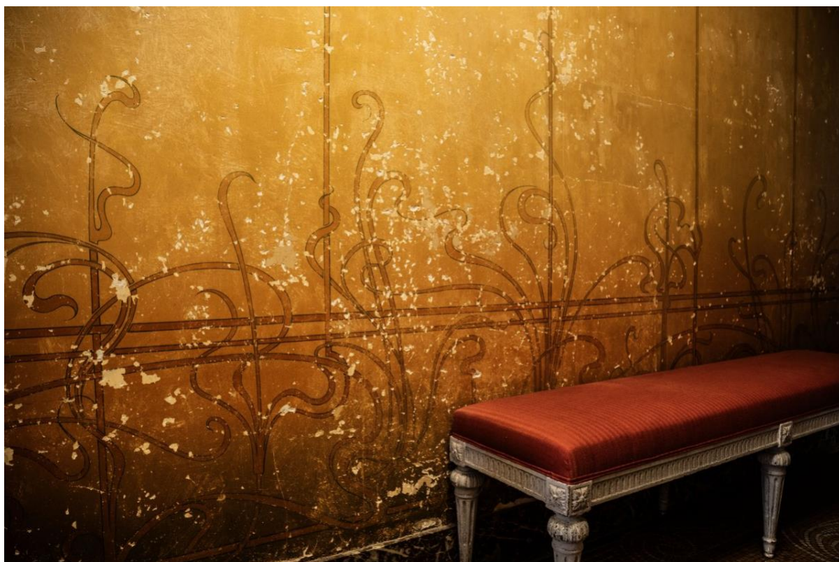
Le décor floral originel de la cage d'escalier, dégagé de ses 12 couches de peinture blanche. ©Saskia Vanderstichele
